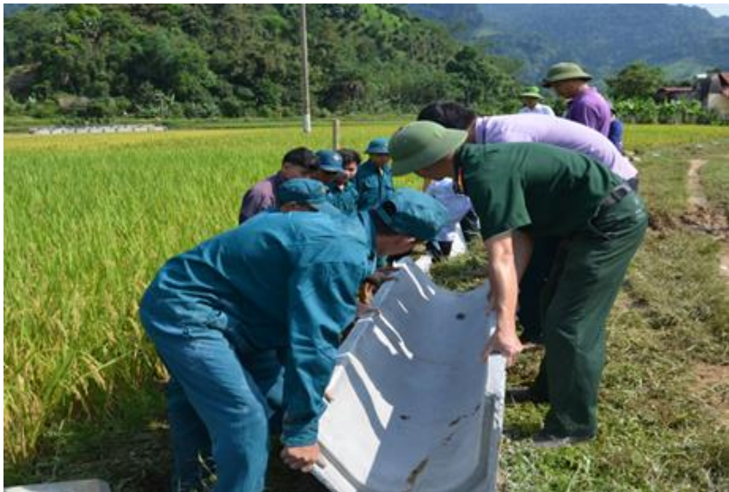
Lực lượng dân quân tự vệ phối hợp với người dân thôn Mường, xã Phù Lưu kiên cố hóa kênh mương bằng cấu kiện bê tông đúc sẵn
